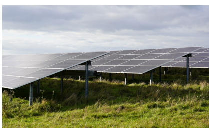
Solcellepaneler på faste stativer.
